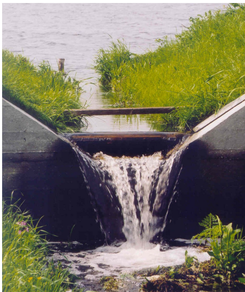
przelew – rzędna piętrzenia 215,50 - zbiorniki Trzciana – Dyndy.
