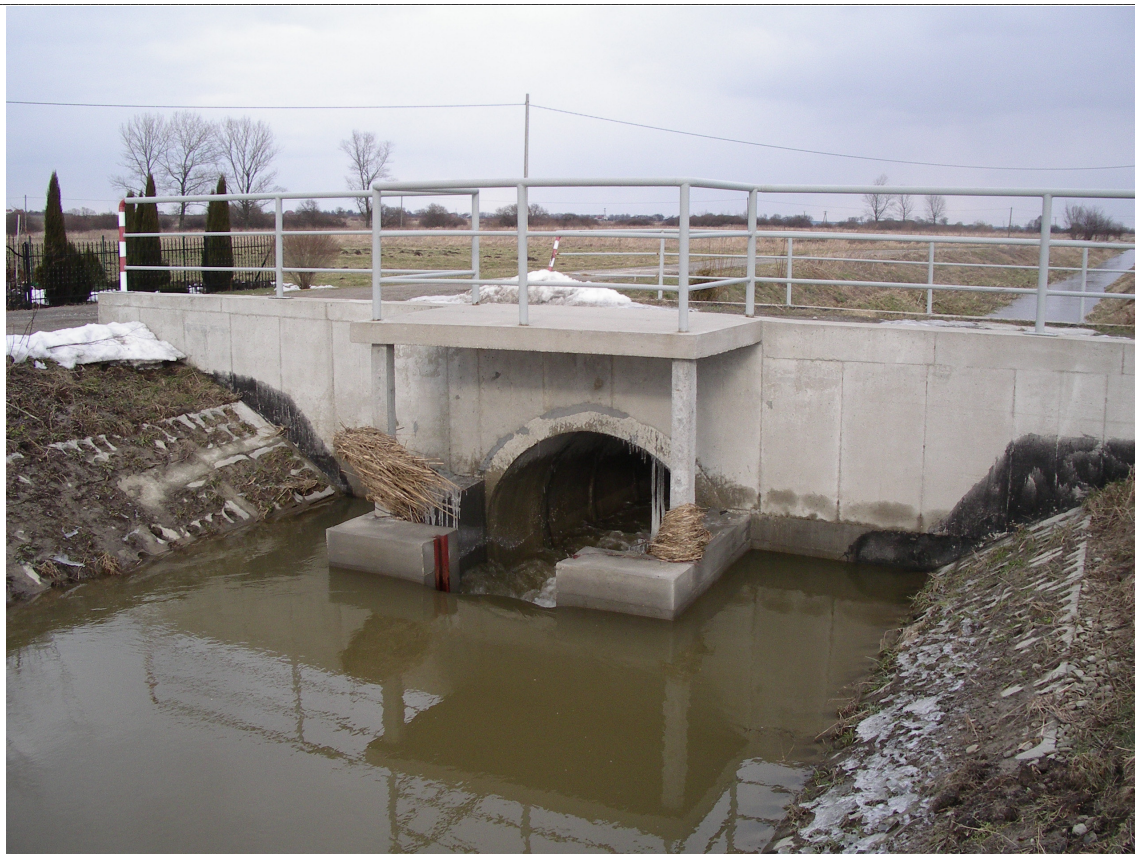
przełaz piętrzący na rzece Mrowla fi200 - Trzciana – Dyndy
