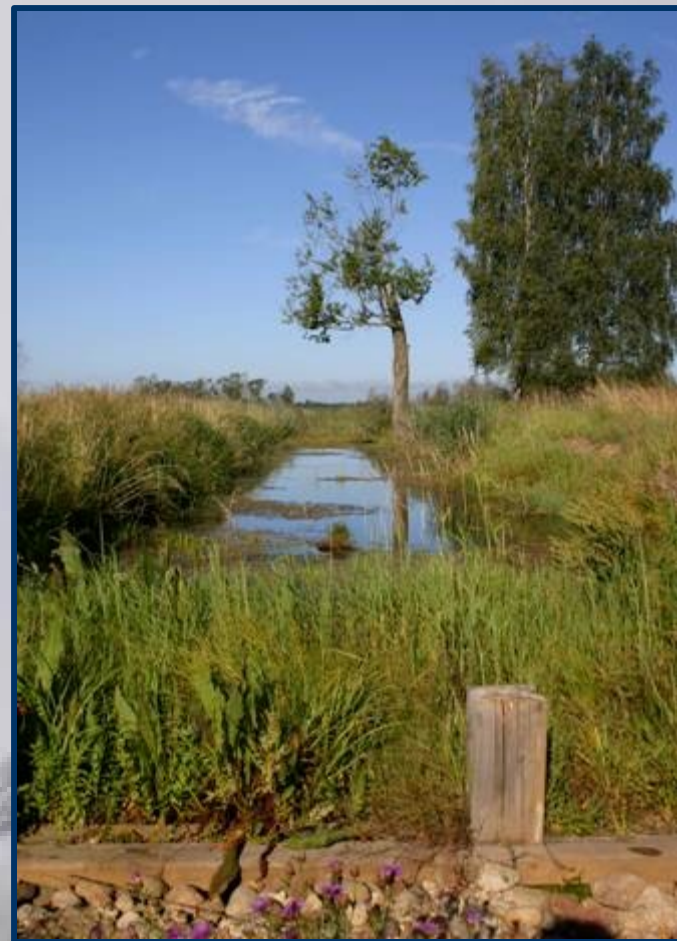
Próg piętrzący na Kanale Wąż
